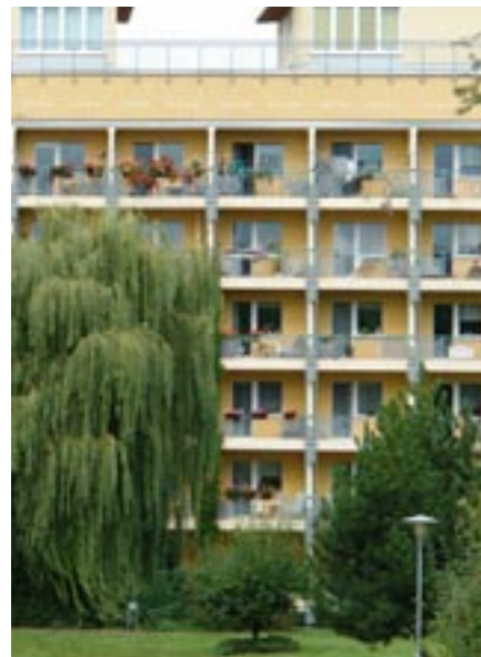
Ansicht Süd des betreuten Wohnens im ersten Bauabschnitt
