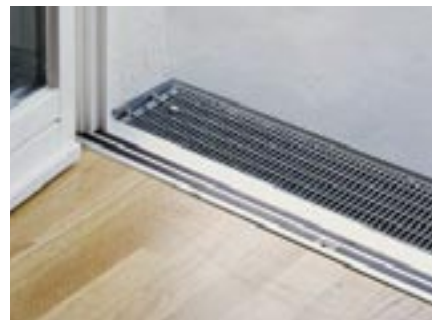
Bild 35: Schwellenfreier Übergang zum Balkon (Neubau und Altbau)
