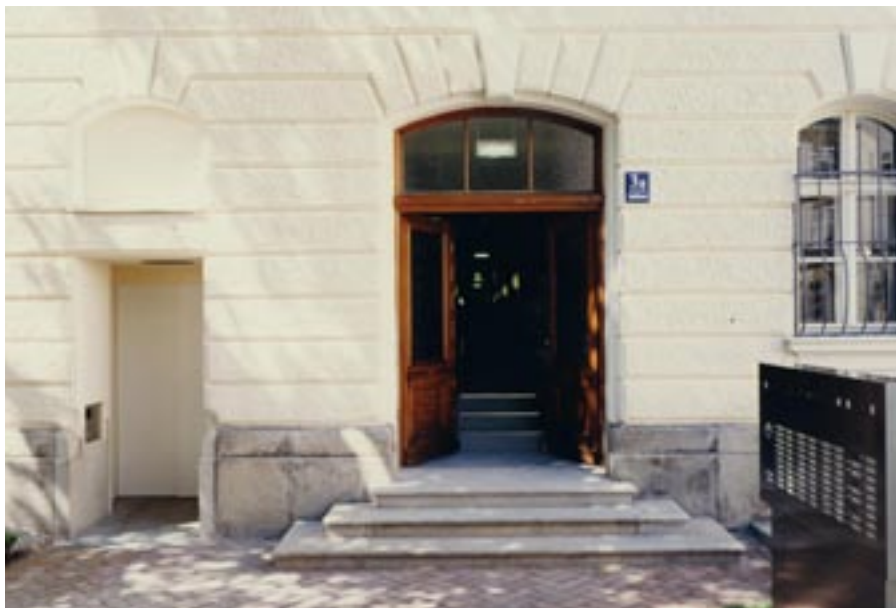
Bild 15: Der Zugang zum Wohngebäude musste erhalten bleiben (Denkmalschutz). Durch den Einbau eines Distanzaufzuges zwischen Außenbereich und Erdgeschoss wird das Gebäude barrierefrei.
