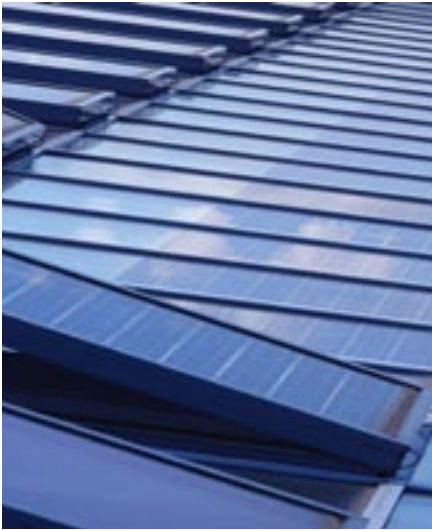
Glasdach mit integrierter PV von oben
