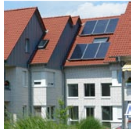
Photovoltaikanlage als Hinweis auf das engagierte Heizkonzept
