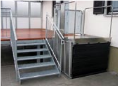
Bild 24: Hubplattform für die Überwindung kleiner Höhenunterschiede
