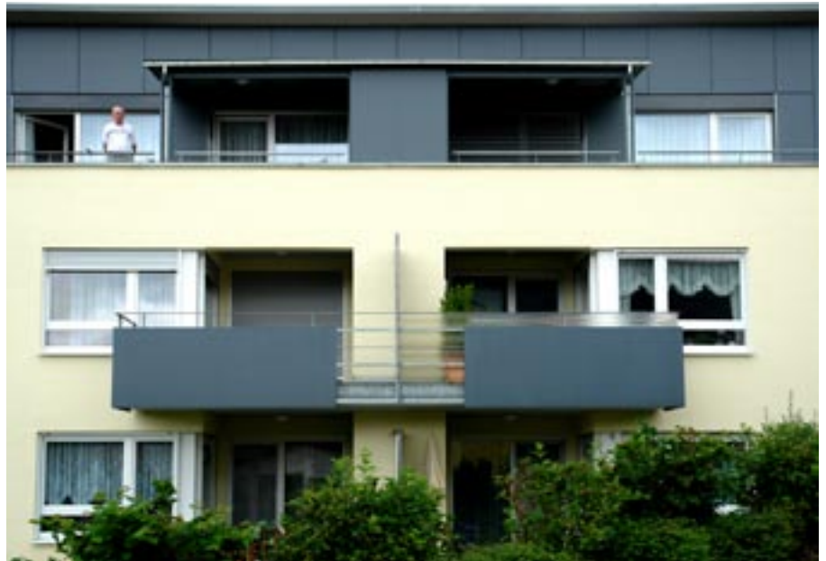
Ausschnitt der Südfassade mit Blick auf die Balkone
