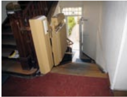
Bild 25: Treppenlift erschließt das Nebentreppenhaus
