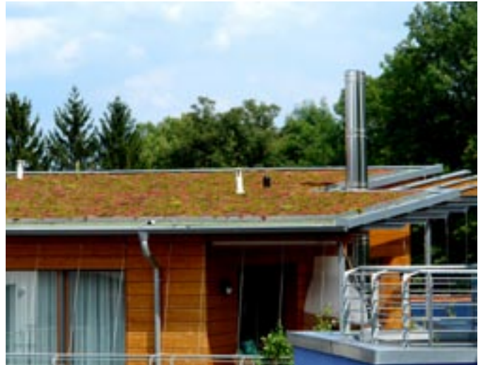
Extensive Dachbegrünung auf flach geneigtem Pultdach
