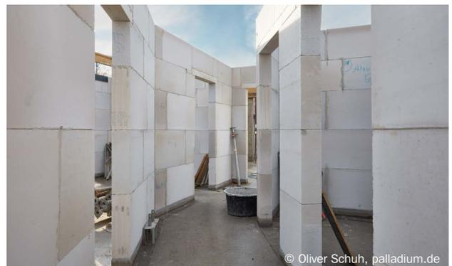
Durch großformatige Regelelemente und vorgefertigte Passelemente reduziert KS-PLUS die Arbeitszeiten auf der Baustelle.
