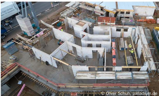
Der aktuelle Rohbau an der Saerbecker Straße: Die Bauherren setzen auf großformatige KS-PLUS Elemente.
