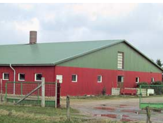
Schweinestall mit vorgehängter Fassade
