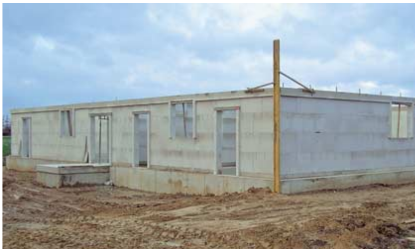
Rohbau eines Schweinestalls in zweischaliger Bauweise
