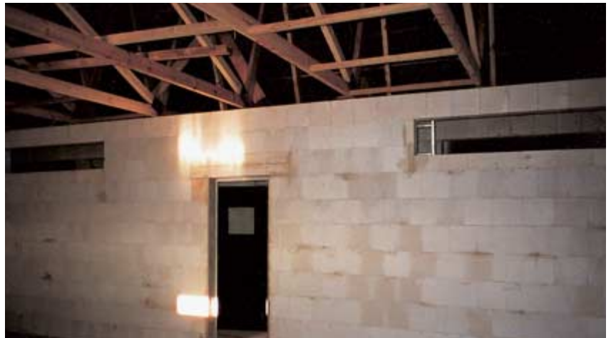
Auflagerung der Binder auf der Trennwand
