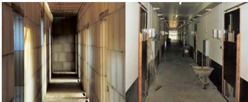
Zentralgang Schweinestall – im Rohbau
