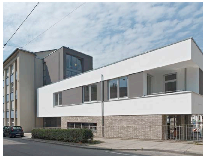
Kalksandstein mit WDVS und Klinkerriemchen im Sockelbereich
