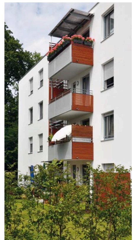
Balkone auf der Südseite
