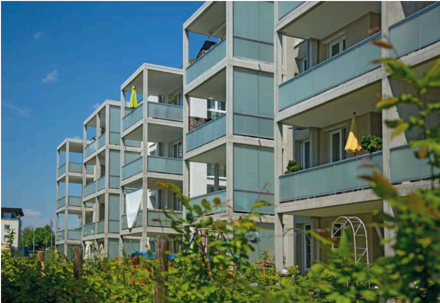
Die Balkone stehen thermisch getrennt vor der Südfassade.
