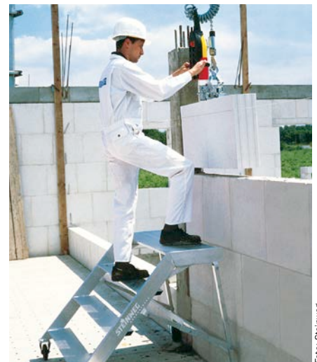
Bild 17: Vermauern von KS XL-Rasterelementen mit Versetzgerät
