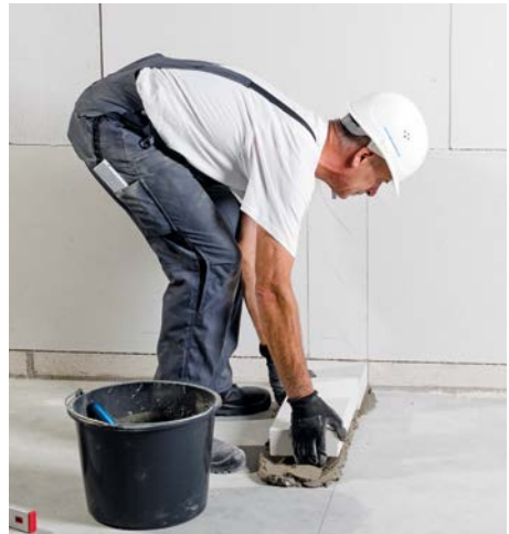
Bild 7 Kimmstein ins Mörtelbett verlegen
