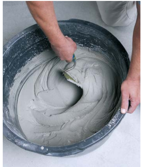
Bild 15 Nach einer Reifezeit und nochmaligem Durchmischen erfolgt die Konsistenzprüfung und Verarbeitung.
