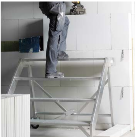
Bild 12 Der Einsatz von fahrbaren Mauertreppen erleichtert das Verarbeiten.
