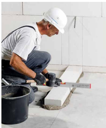
Bild 9 Kimmsteine in Querrichtung ausrichten
