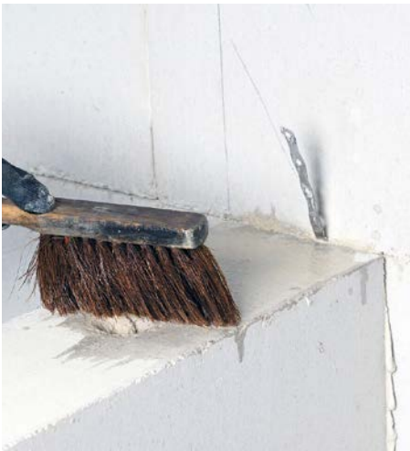
Bild 6 Bei hohen Außentemperaturen sind die Steine vorzunässen.
