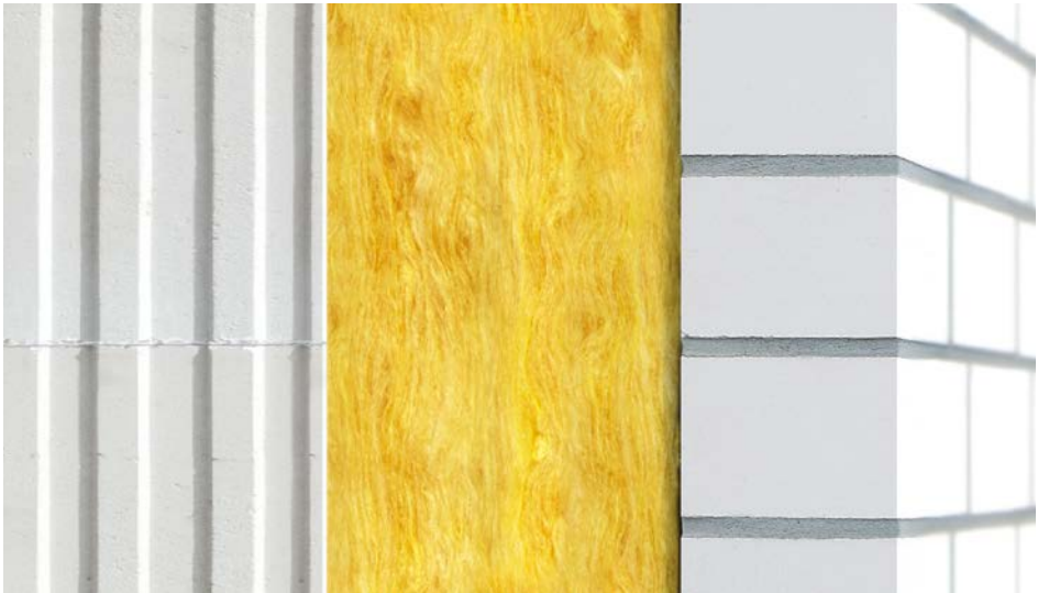
Bild 2 Zweischaliger Wandaufbau mit Hintermauerung, Dämmung und Verblendung
