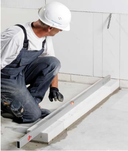
Bild 10 Kimmsteine in Längsrichtung ausrichten
