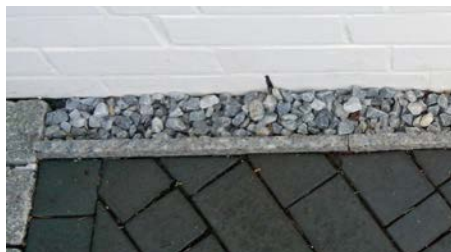
Bild 43 Beispiel für eine Fußpunktausbildung mit Kiesrandstreifen
