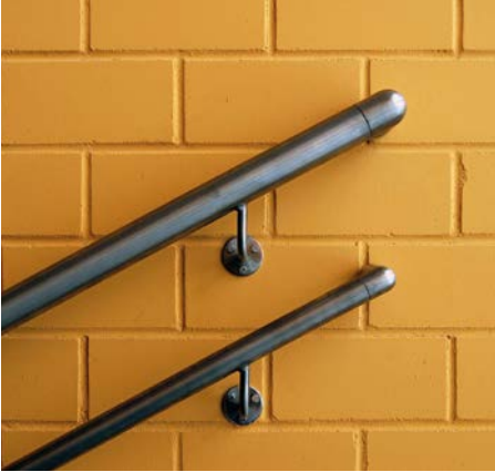
Bild 10 Befestigung von Treppengeländern an KS-Mauerwerk
