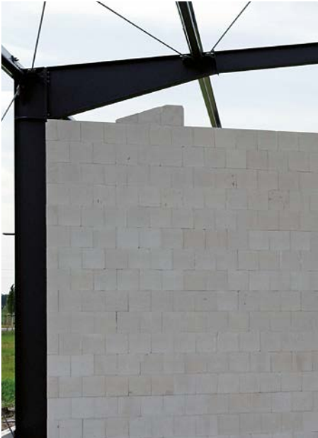
Bild 24 Kalksandstein-Mauerwerk als Ausfachung einer Stahlkonstruktion
