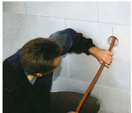
Bild 6 Einziehen eines Leerrohres
