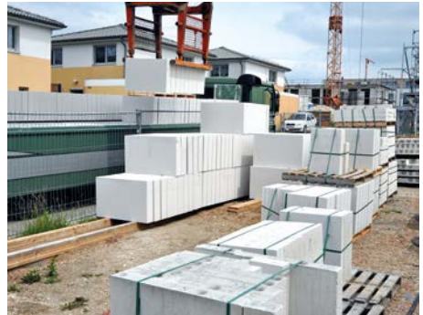
Bild 6 Das Absetzen der Stein stapel erfolgt zweckmäßig auf Paletten oder Bohlenlege.
