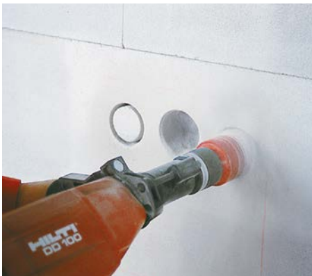
Bild 5 Fräsen von Öffnungen für Schalterdosen
