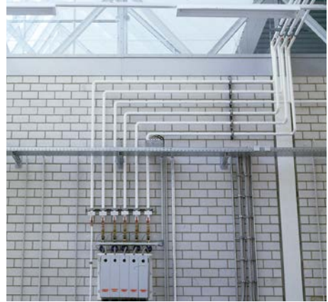
Bild 11 Innensichtmauerwerk aus Kalksandstein mit befestigten Installationsleitungen
