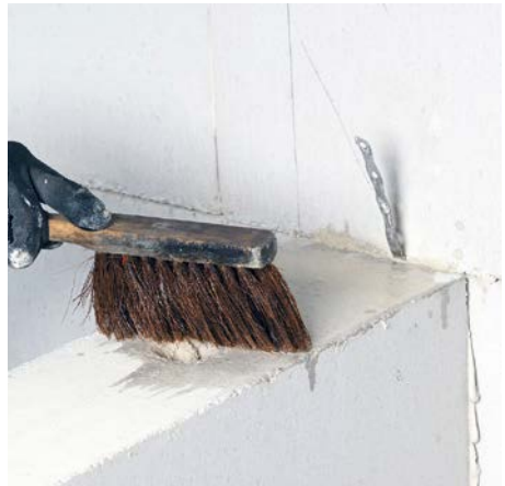
Bild 28 Bei starker Hitze ist das Vornässen der Mauersteine notwendig.
