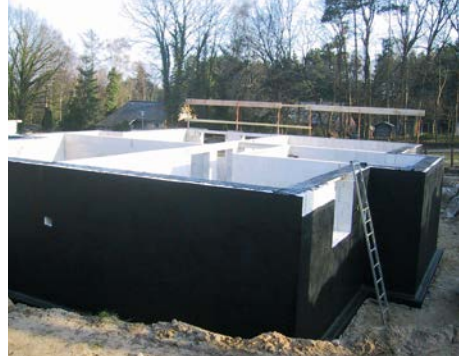
Bild 3 Kellerwand-Außenseite mit PMBC-Abdichtung
