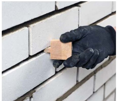
Bild 29 Auskratzen der Fugen mit einem Holzbrettchen
