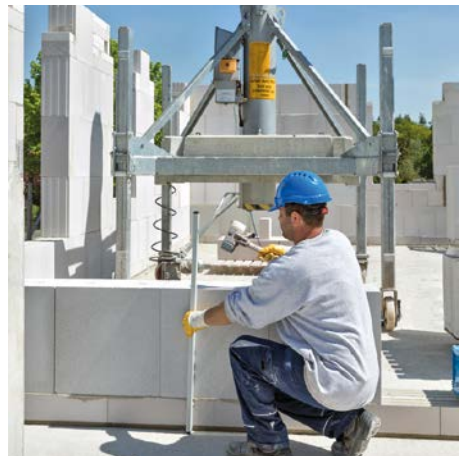
Bild 13 Eine gute Baustellenorganisation ermöglicht durchgängiges Arbeiten.
