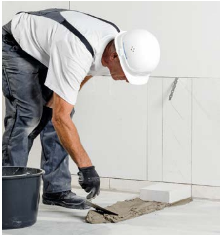
Bild 6 Mörtel auf die Betonsole auftragen
