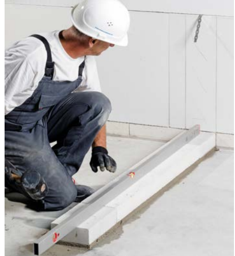
Bild 9 Kimmsteine in Längsrichtung ausrichten
