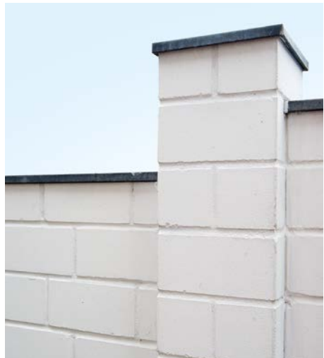
Bild 27 Gemauerter Pfeiler aus KS-Verblendern
