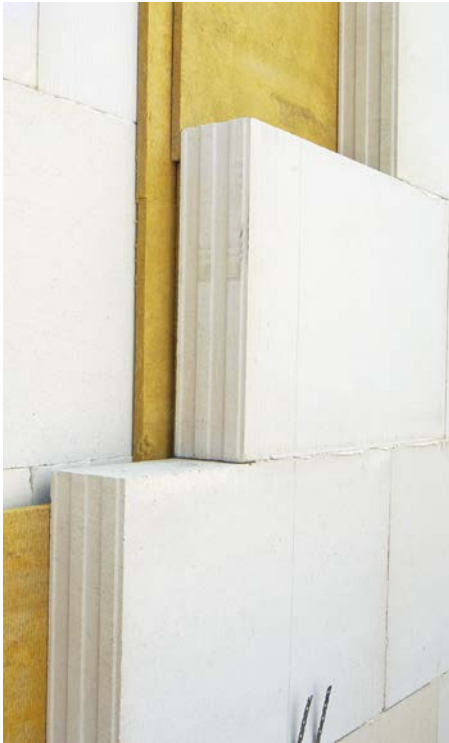
Bild 47 Dicht gestoßene Mineralfaserplatten Typ WTH vermeiden Schallbrücken.
