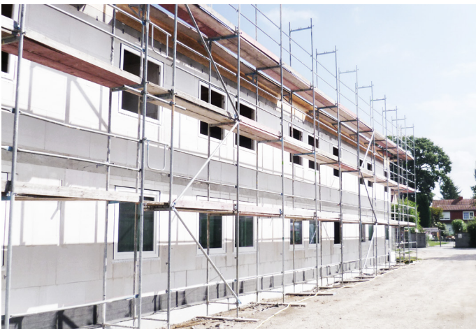
Verkürzung von Bauzeiten durch schnell wachsende Kalksandsteinwände.
