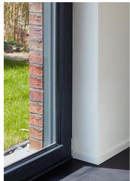
Hinter dem Klinker verbergen sich eine 200 mm dicke Dämmung sowie das massive KS\* Mauerwerk.
