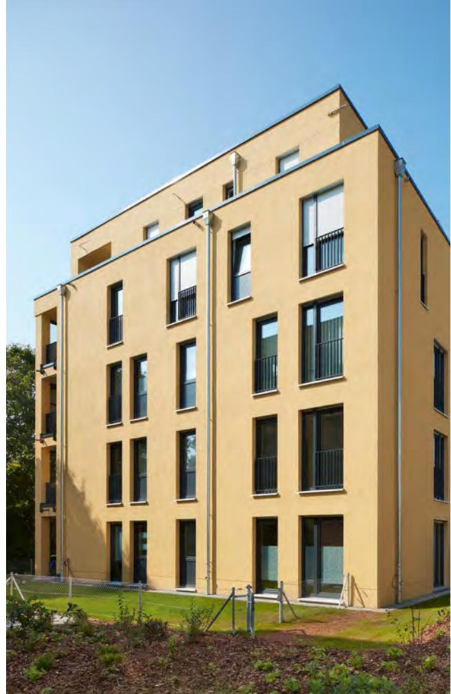
Die flächensparenden schlanken Außenwände entsprechen in der Dicke etwa dem herkömmlichen „36er-Mauerwerk“. Sie vermeiden dadurch den Schießcharteneffekt ungewöhnlich tiefer Fensteröffnungen, erfüllen durch die Funktionstrennung aber trotzdem moderne Standards der Energieeffizienz.
