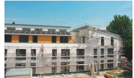
Ansicht Süd (Bauphase)
