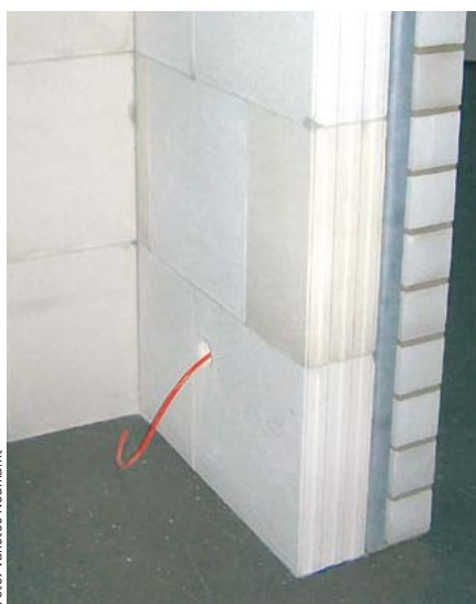
Modell einer zweischaligen Außenwand mit VIP-Dämmung
