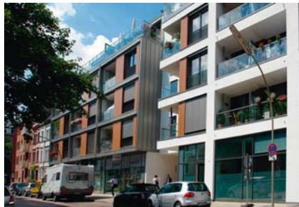
Ansicht Südost aus der Erdmannstraße
