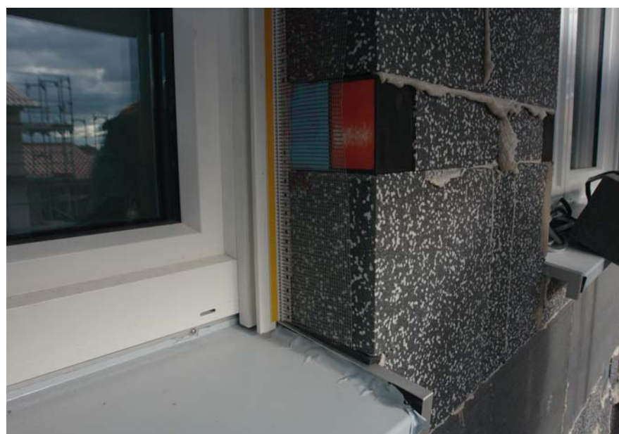
Purenitelement im Wärmedämmverbundsystem zur wärmebrückenoptimierten Befestigung eines Brüstungsstabs an einem Fenster
