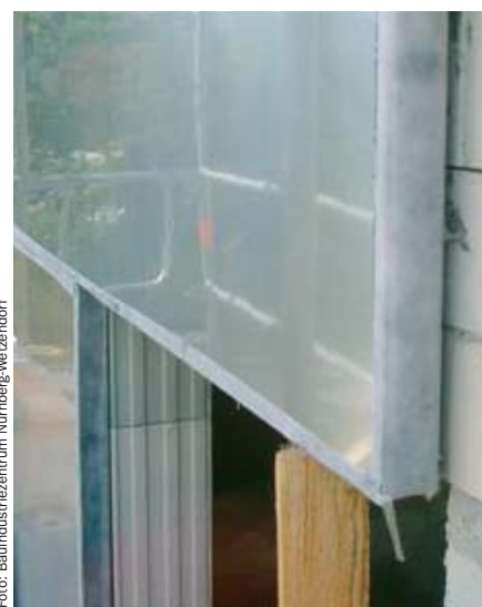
VIP-Dämmung im Bereich der Fenster
