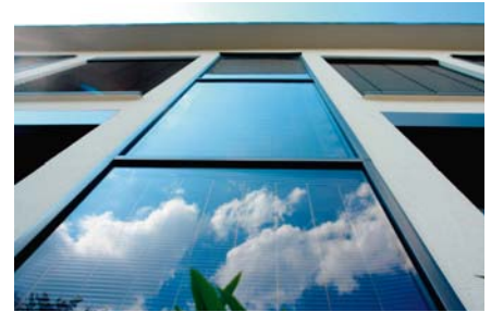
Fassadenintegrierte Solarthermielelemente
