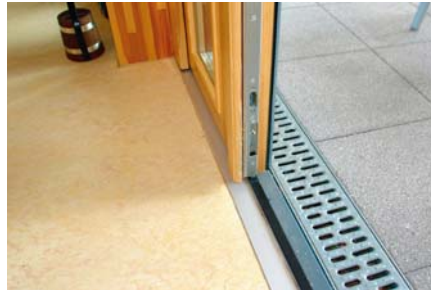
Einbau eines Fensters: barrierearme Schwelle
