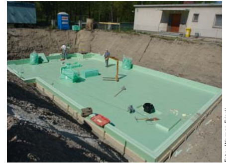
Dämmung unter Bodenplatte
