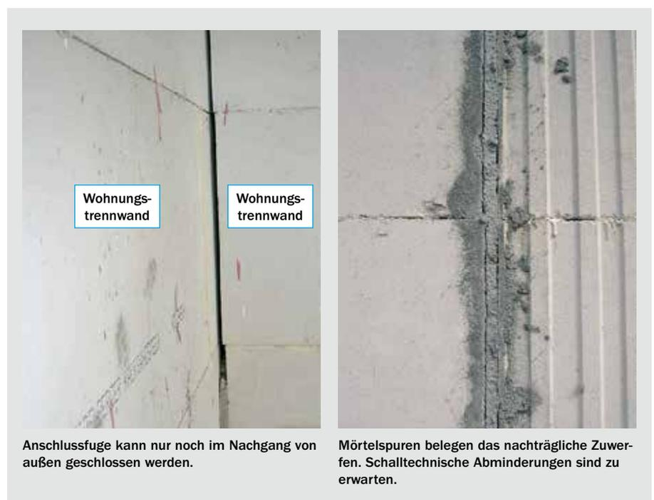
Bild 28: Nicht vermörtelter bzw. nachträglich vermörtelter Stumpfstoß
