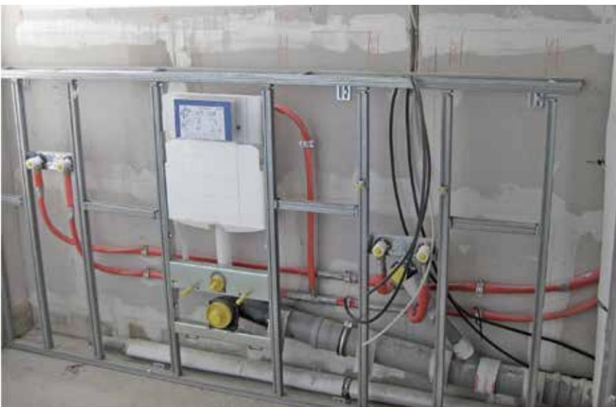
Bild 32: Vorwandinstallation mit verspachtelten Mauerwerksfugen
