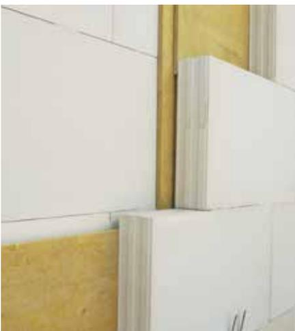
Bild 37: Dicht gestoßene Mineralfaserplatten Typ WTH vermeiden Schallbrücken.
