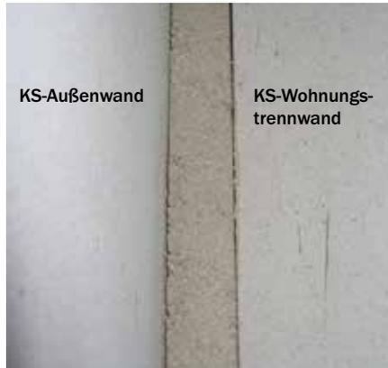
Bild 21: Wohnungstrennwand an Außenwand mit beidseitig gelöster Mörtelfuge
