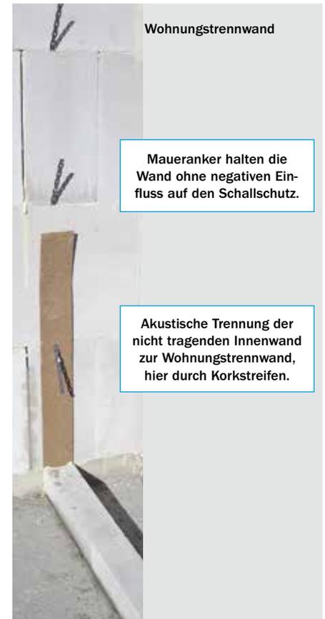
Maueranker halten die Wand ohne negativen Einfluss auf den Schallschutz.
